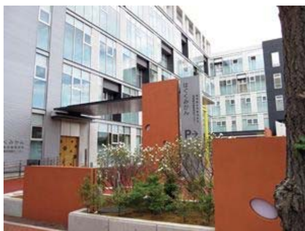
はぐくみかん施設外観
