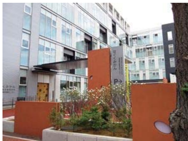
はぐくみかん施設外観
